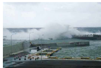
▲ 西防波堤整備前の越波状況 (提供:函館開発建設部)
