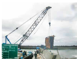
▲ 打設用の型枠設置中
