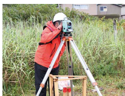
▲ 型枠が並行になるよう測量
