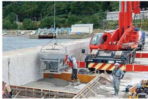
防波堤上部のコンクリートを削り、物揚場用のコンクリートを打設する
