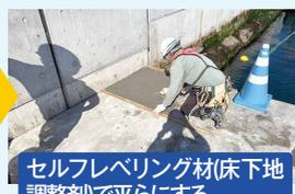
セルフレベリング材(床下地調整剤)で平らにする
