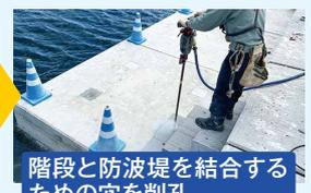
階段と防波堤を結合するための穴を削孔
