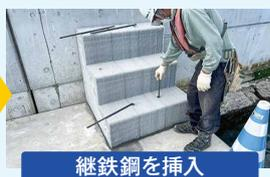
継鉄鋼を挿入
