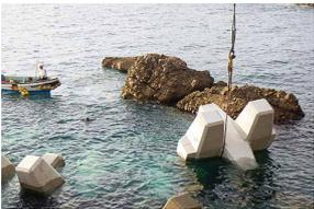
既設ブロック(12t型)を撤去し、合掌ブロック(20t型)に置き換え
