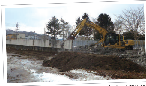
▲プール解体状況
