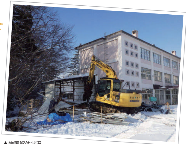
▲物置解体状況
