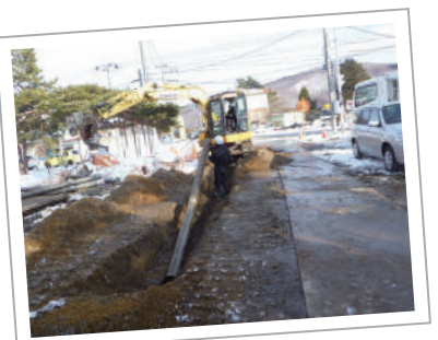
▲排水管撤去状況
