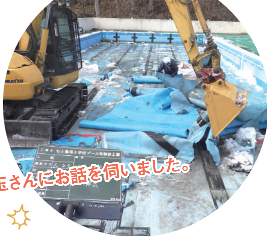
▲プール防水シート解体状況
