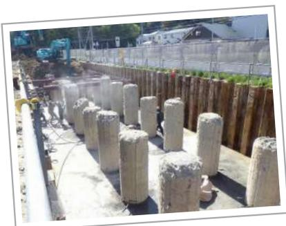
▲本體工(場所打ち杭)杭頭処理作業
