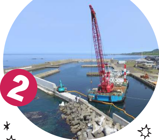
▲清部漁港南防波堤 消波ブロック撤去状況
