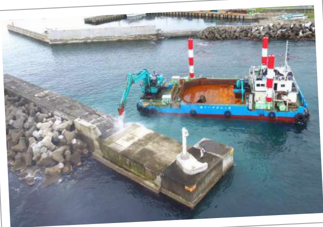
▲清部漁港西防波堤 既設コンクリート撤去取壊し状況
