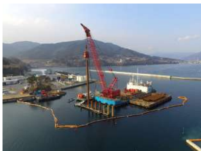
▲鋼管杭打設状況
