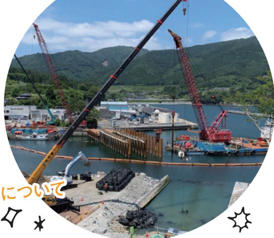
(奥) 鋼管杭打設、第七すがわら号。(手前) 潜水士による土嚢設置状況▲
