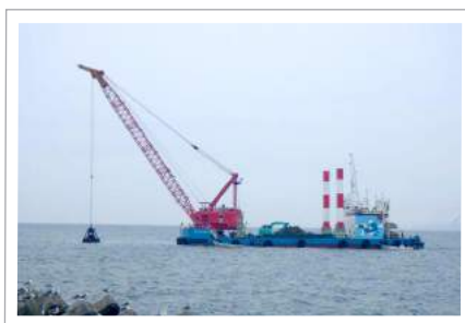
▲起重機船による石材投入
