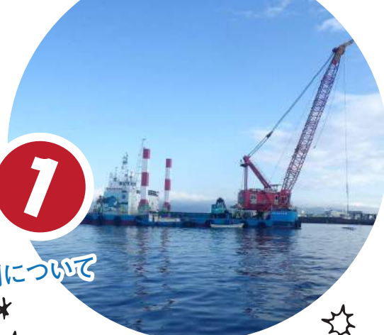
▲起重機船による囲いブロック据付
