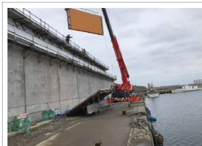
▲クレーンで吊り上げ型枠を設置
