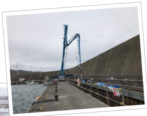
▲ポンプ車でコンクリート打設 ▼バイブレーターをかけています
