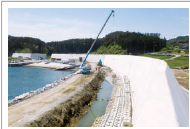
▲令和1年5月 仮設道路撤去前に水中部をブロック保護がっちり！
