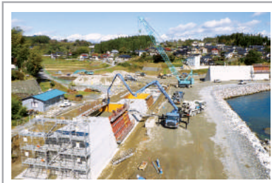
▲平成28年11月 高さ10.9m、防潮堤コンクリート始めました。
