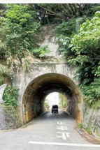
1919年開通 沖縄初の 手掘りトンネル
