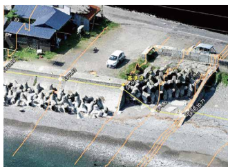
▲ 工事前の点群データ
