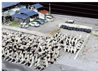
▲ 工事後の点群データ
