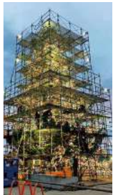
ツリーに電飾を設置し、点灯テスト
