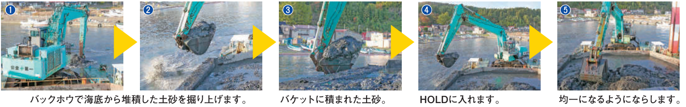
バックホウで海底から堆積した土砂を掘り上げます。
