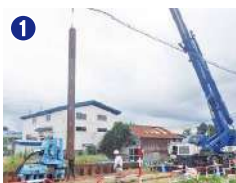
1 クレーンで吊り下げられているのが止水網矢板(8m)
