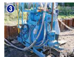
3 ボーリングマシンで所定の深さまで穴を開ける
