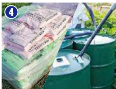
4 注入する2種類の薬液 硬化剤(左)と水ガラス(右)
