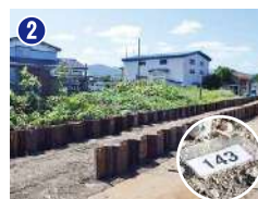
2 埋め込まれた止水網矢板、薬液注入のポイントに番号札を置く
