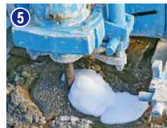
5 ボーリングマシンで地中に薬液を注入(白く見えるのが薬液)
