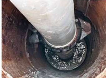
ケーシング管内部(海水の流入なし)
