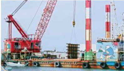
クレーンによる型枠の設置作業
