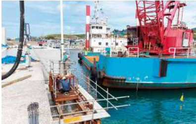
水中コンクリート打設(ケーシング工法)
