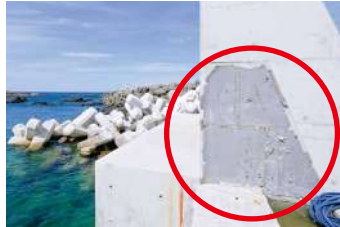
濃く見ると元々の堤防の大きさ
