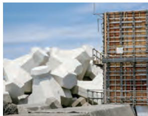
型枠と消波ブロック
