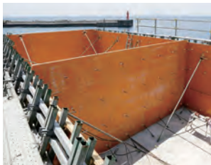
ここにコンクリートを流し込みます
