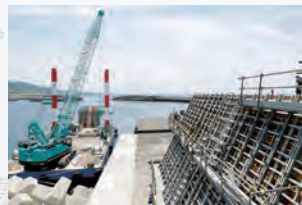
作業船(左)と胸壁の型枠(右)
