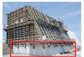
赤枠の部分に 「バジリスクコンクリート」 が使われています
