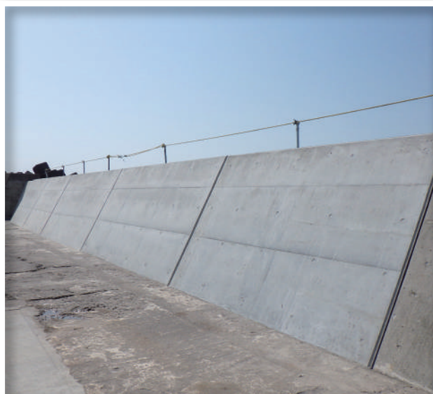
胸壁コンクリート 高さ:2.5m 長さ:25m
