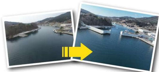
日本初の海底設置型フラップゲート式水門の設置をしました。既に水門函体は完成しており、水深-11.5mの海底に設置された56本の鋼管杭が函体のさや管で接合さ
