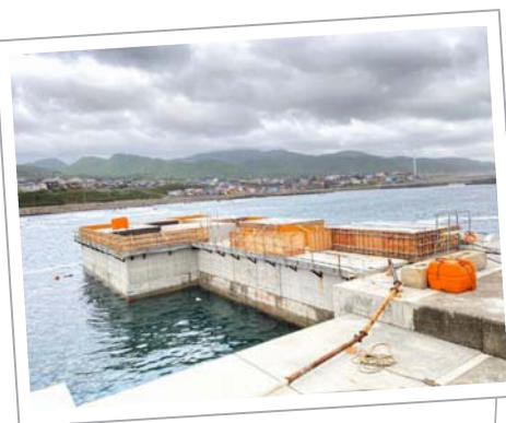
▲江良漁港 波除堤上部
