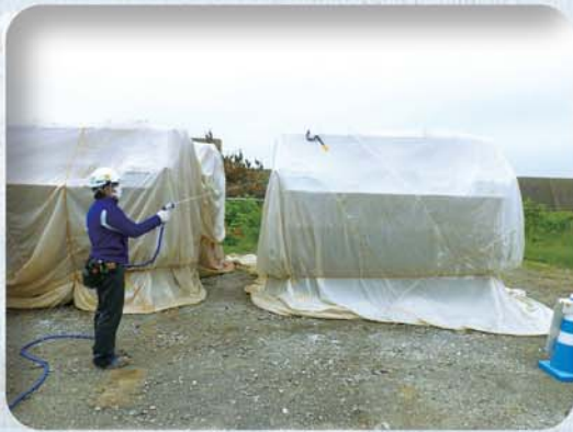
▲大島漁港工事ブロック散水養生
