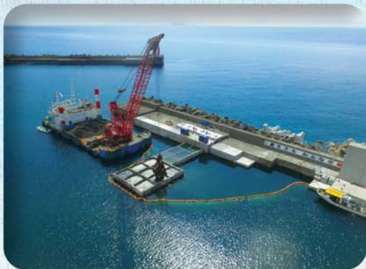
▲ケーソン中詰工
